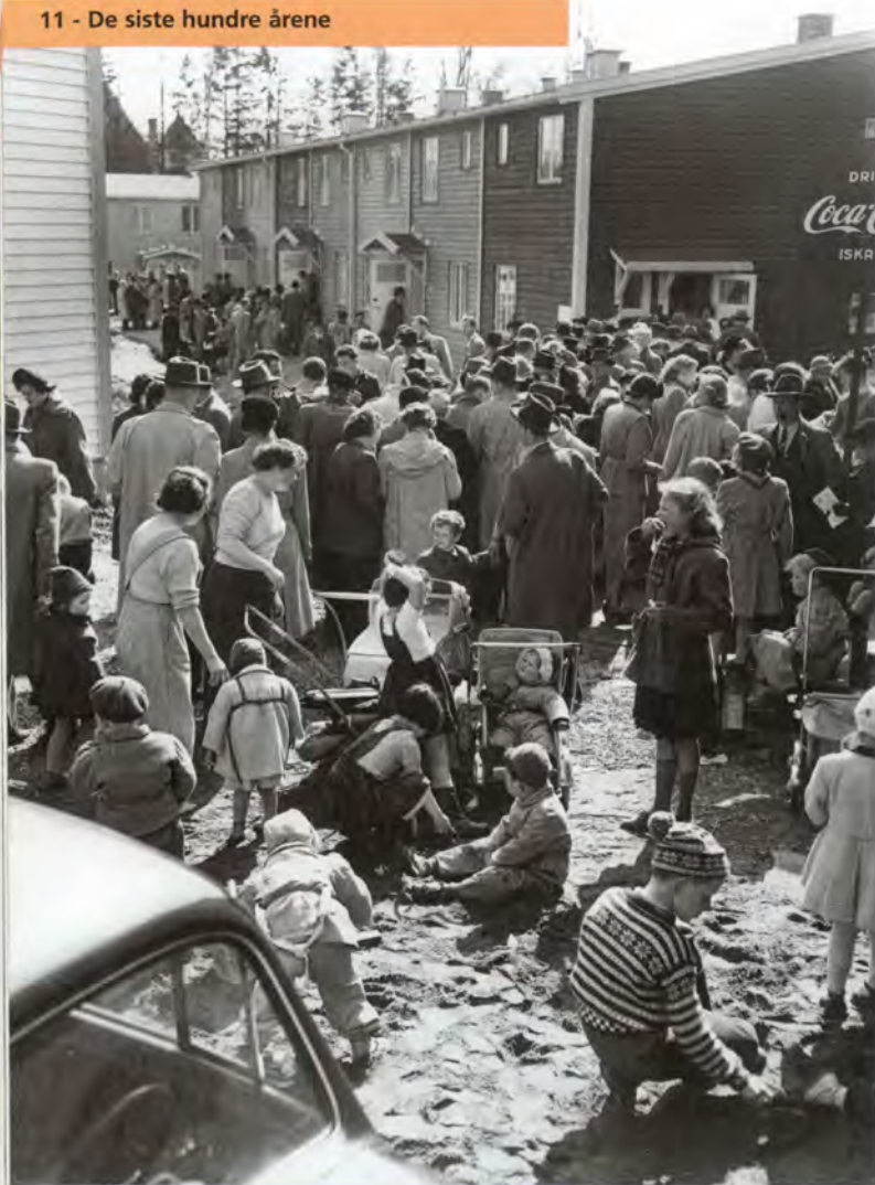
I Oslo bygde ingeniør Olav Selvaag svært rimelige boliger etter krigen. Det var flere enn én som møtte fram på visningene
